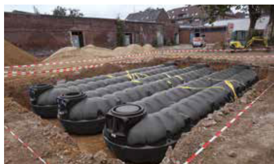
Installasjon NEO buffertank 3 x 20 000 l
